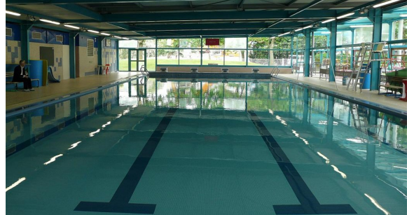
Piscine de La Lévière, Créteil
