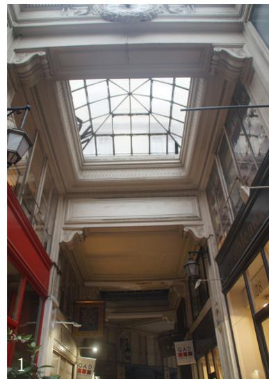
Ces perceptions acoustiques de l'espace sont dues au carrelage au sol qui reflète le bruit des talons, aux vitres en façades et à la verrière, aux caissons pleins en plâtres aux entrées du passage, à la coudée d'une des extrémité et aux deux caissons emprisonnant le son en verre (figure 1). L'ouverture et la volumétrie de la verrière permettent d'emprisonner les sons résiduels, ce qui est montré dans les croquis analytiques ci-dessus.
